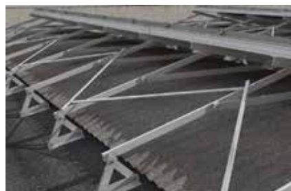
Dettaglio: fissaggio controvento
