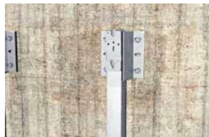
Dettaglio: collegamento staffa al montante
