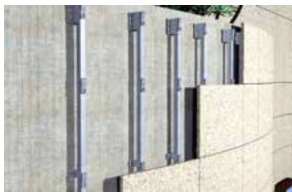
Facciata con lastre curve
